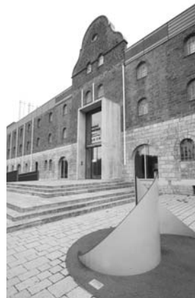
FASSADE des Kulturspeichers
